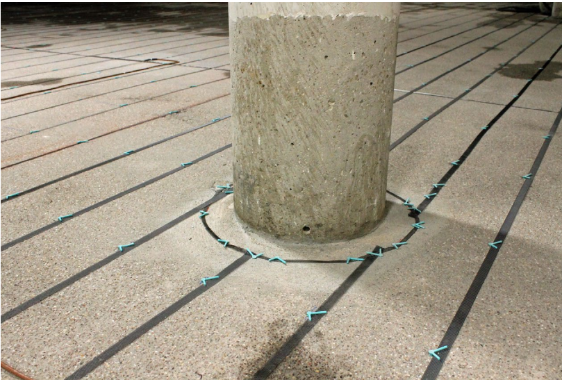
1425 – 1 Vorbereitung mit Anoden.jpg
